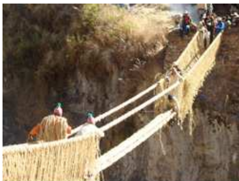
The chakaruwaq or "bridge makers" at work, Victoriano Arizapana and Hilario Cayo, members of the Huinchiri community. © Dirección de Registro y Estudio de la Cultura en el Perú Contemporáneo - Ministry of Culture
