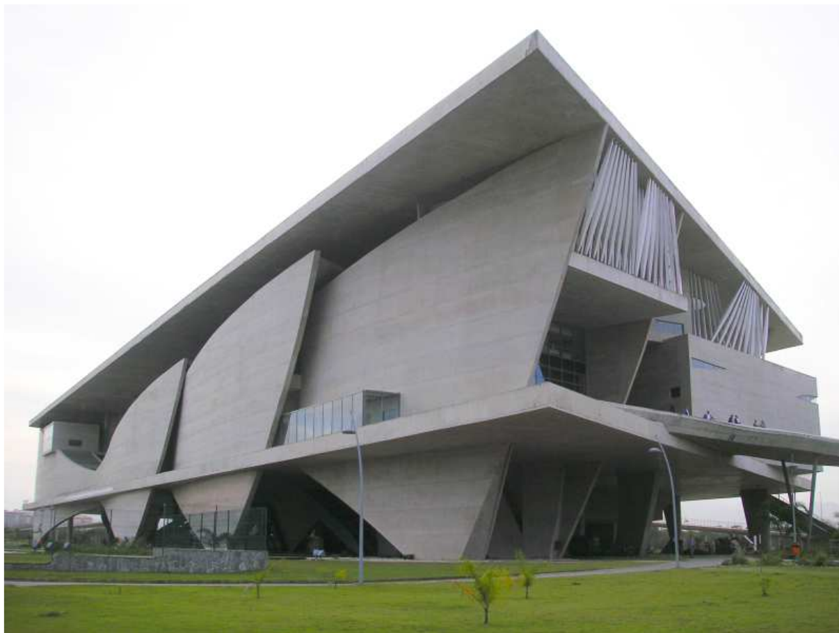
Cidade das Artes, Rio de Janeiro, architektonický návrh Christian de Portzamparc, návrh 2002, dokončeno 2013
